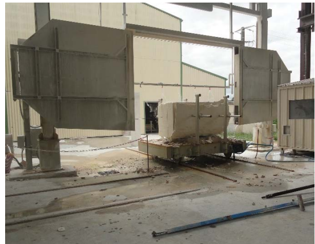
Le sciage de blocs au niveau des ateliers
